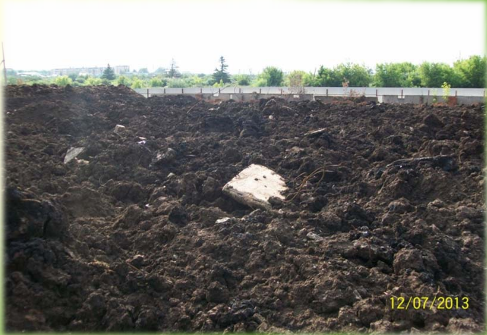
Участок ДО РЕКУЛЬТИВАЦИИ (видны крупные обломки железобетонных шламовых амбаров).
